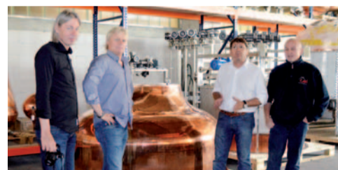
Besichtigung der Brennanlage
